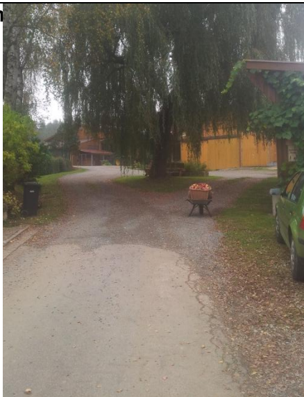
beschädigte Straße zu den Höfen = Wanderweg
