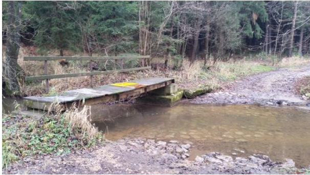
Fußgängerbrücke nach Leite
