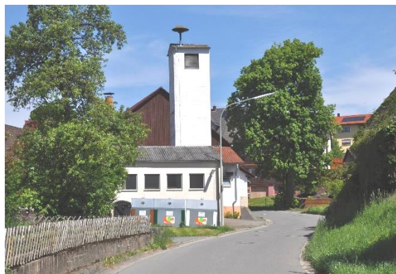
Alte Feuerwehr im historischen Ortskern
