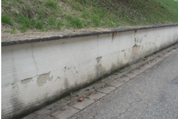
Mauer östlich von Bodendorf 4
