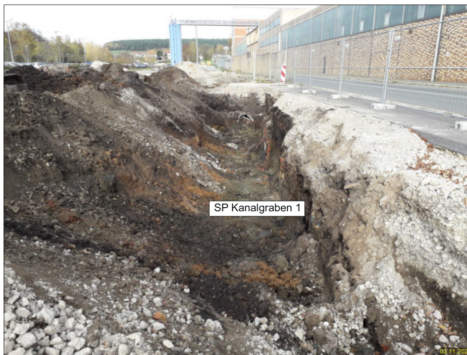
Bild 9: Südlicher Kanalgraben während des Aushubs am 03.11.2022 mit Darstellung der Probenahmepunkte, Aufnahme noch während der laufenden Aushubarbeiten, Blickrichtung Nord
