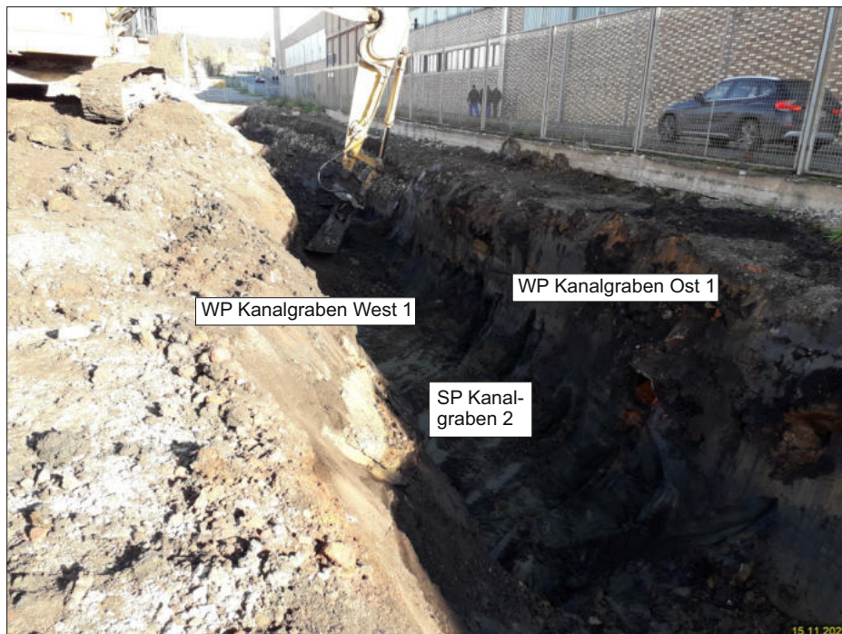
Bild 12: Nördlicher Kanalgraben vom 15.11.2022 mit Darstellung der Probenahmepunkte, Blickrichtung Nord
