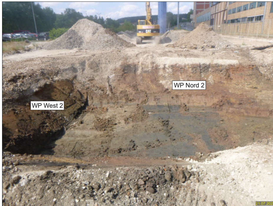
Bild 7: Sanierungsgrube am 21.07.2022 mit Darstellung der Probenahmepunkte, Blickrichtung Nord
