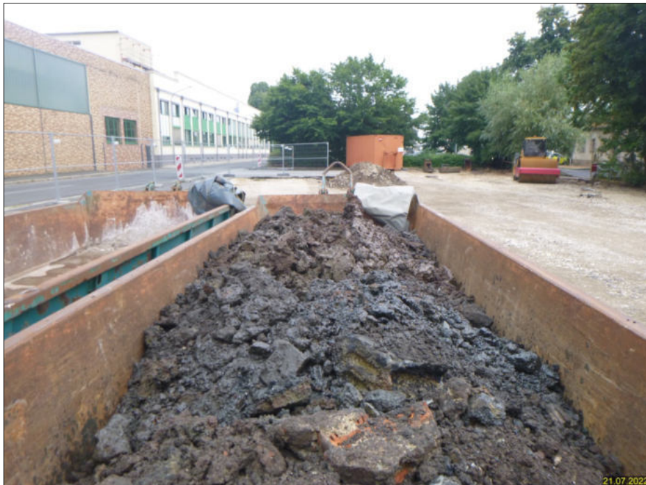
Bild 4: Ansicht des Aushubmaterials im Container
