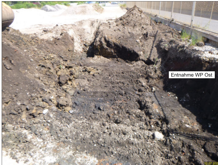
Bild 1: Aushub der Sanierungsgrube am 12.07.2022 mit Darstellung der Probenahmepunkte, Blickrichtung Nord
