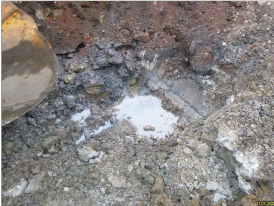
Bild 3: Schichtwasser während der Aushubarbeiten, Entnahme der Probe „Schichtwasser“ am 21.07.2022
