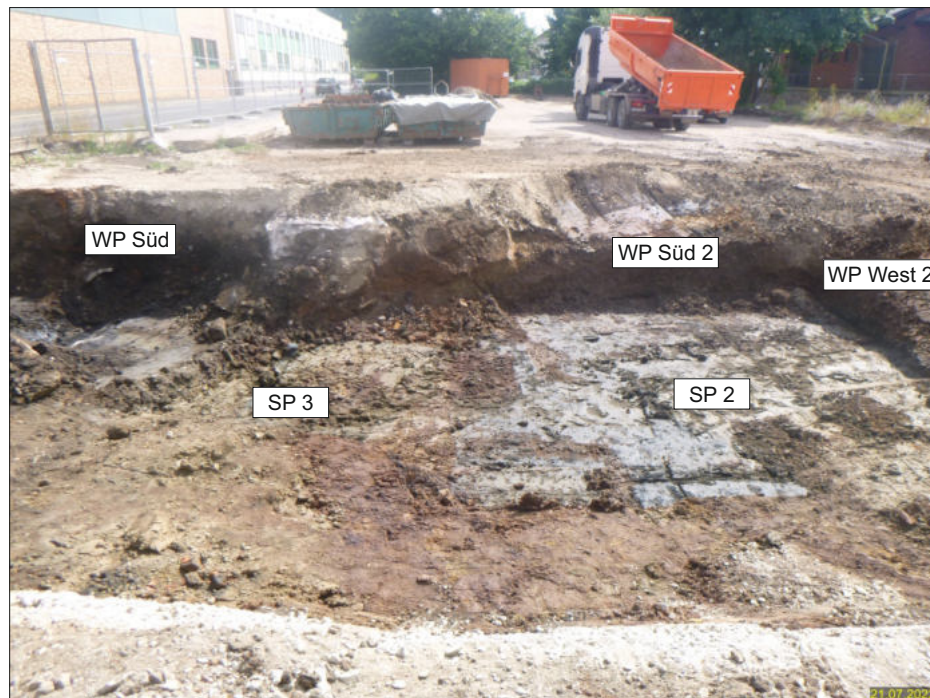
Bild 6: Sanierungsgrube am 21.07.2022 mit Darstellung der Probenahmepunkte, Blickrichtung Süd
