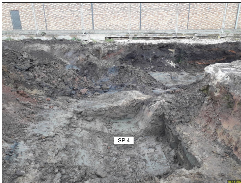
Bild 10: Sanierungsgrube am 10.11.2022 mit Darstellung der Probenahmepunkte, Blickrichtung Ost
