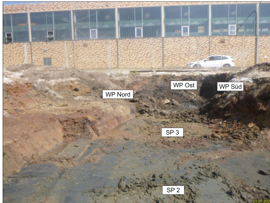
Bild 5: Sanierungsgrube am 21.07.2022 mit Darstellung der Probenahmepunkte, Blickrichtung Ost
