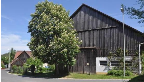
Scheune in der Hufeisenstraße
