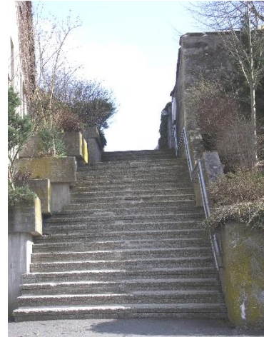
Fußweg mit Treppenanlage zwischen Kirche und Kindergarten
