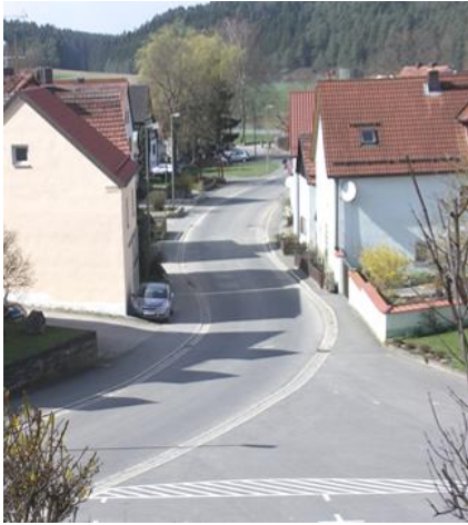
Klumpetalstraße, Blick von Osten
