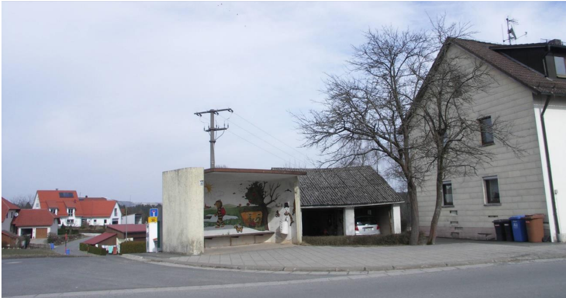
Sanierungsbedarf im Bereich der Bushaltestelle
